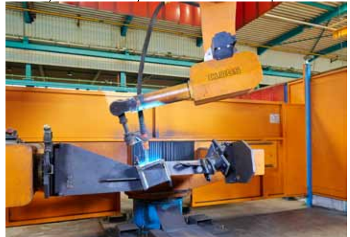
Bild 1: Die Kompaktanlage ist seit 2008 erfolgreich im Einsatz.
