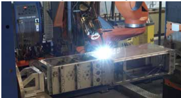
Bild 1: Mit der CLOOS-Roboteranlage schweißt Driescher-Wegberg Gehäuse für Schalteranlagen..
